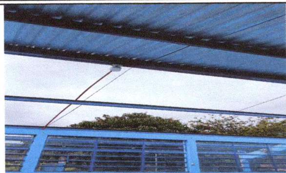
Foto 1: Mejoramiento de techo con láminas troqueladas.
