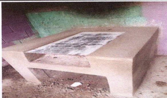
Foto 4: Mejoramiento de cocina con instalación de estufa con ladrillo y chimenea.
